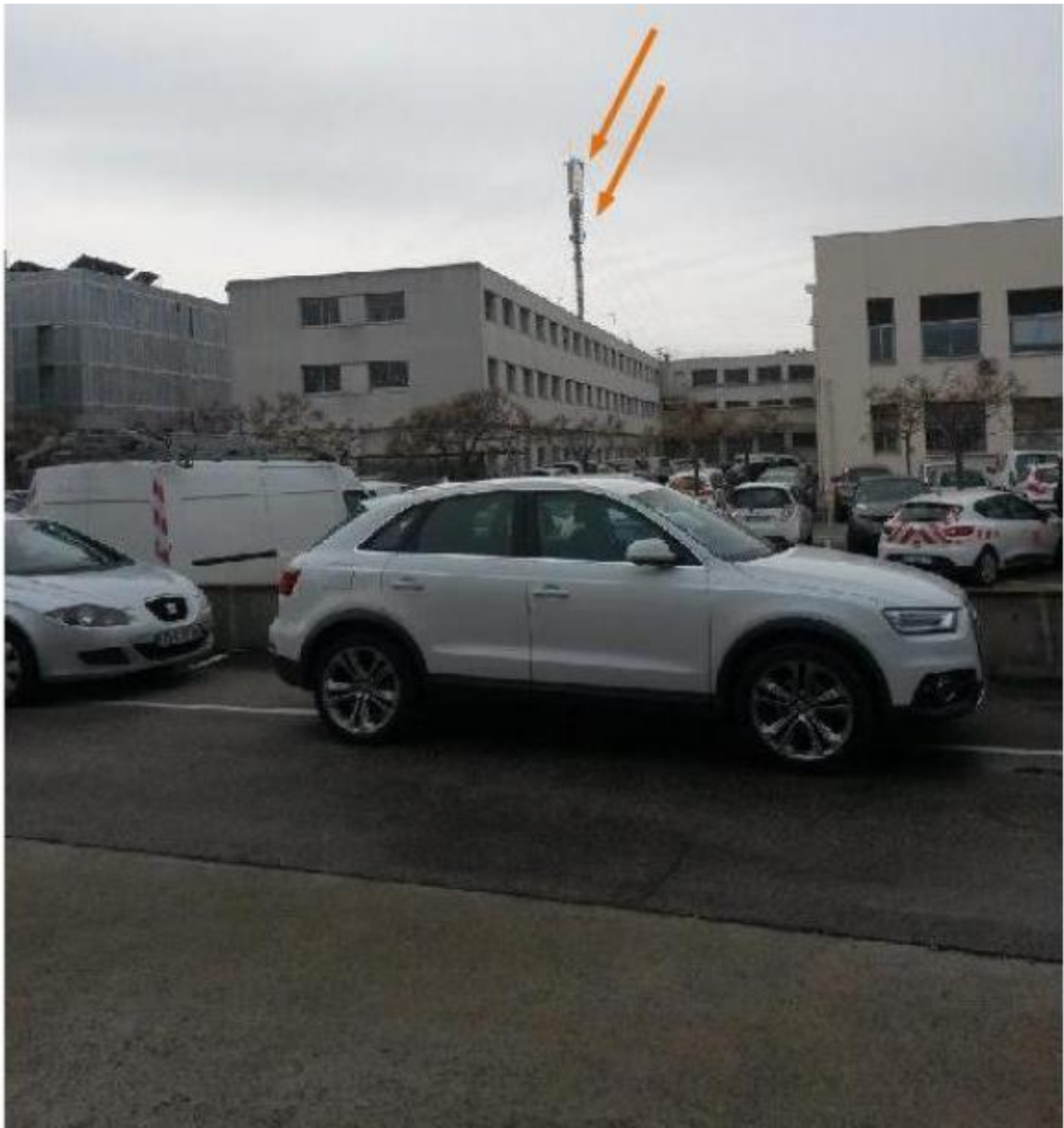
vue 1 : photo du site existant depuis l'arrière du bâtiment de l'avenue du marché Gare.
