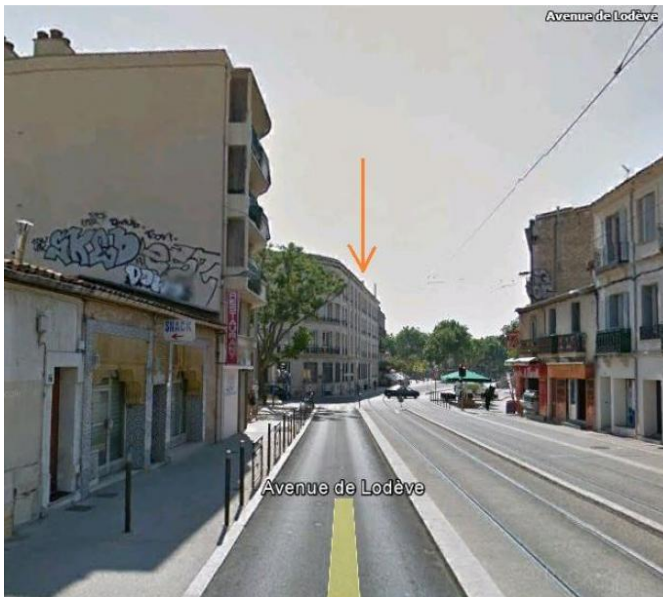
vue 1 : Photo du site existant depuis l'avenue de Lodève. Pas de modification visuelle après le changement des antennes.
