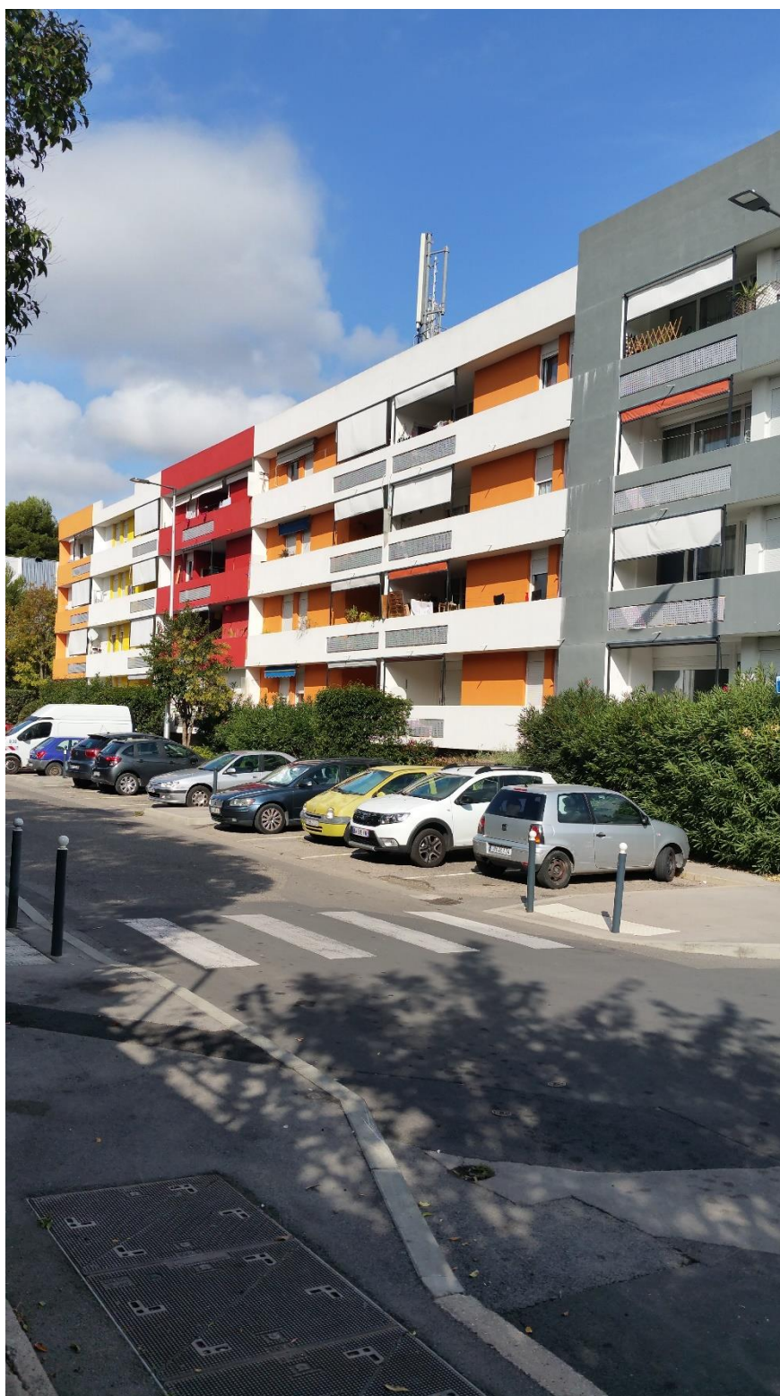
VUE 2 de près avant travaux
